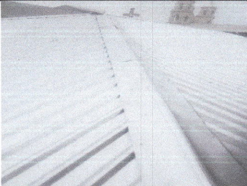
Foto No. 3. CAMBIO DE TECHADO Y CAPOTES
