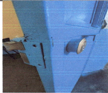
Foto No. 2. CAMBIO DE CHAPAS DE AULAS
