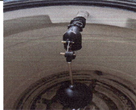
Foto No. 4 CAMBIO EFECTUADO EN ACCESORIOS DEL DEPOSITO DE AGUA.
