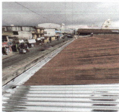
Foto No. 7. Cambio efectuado de canales del centro educativo.
